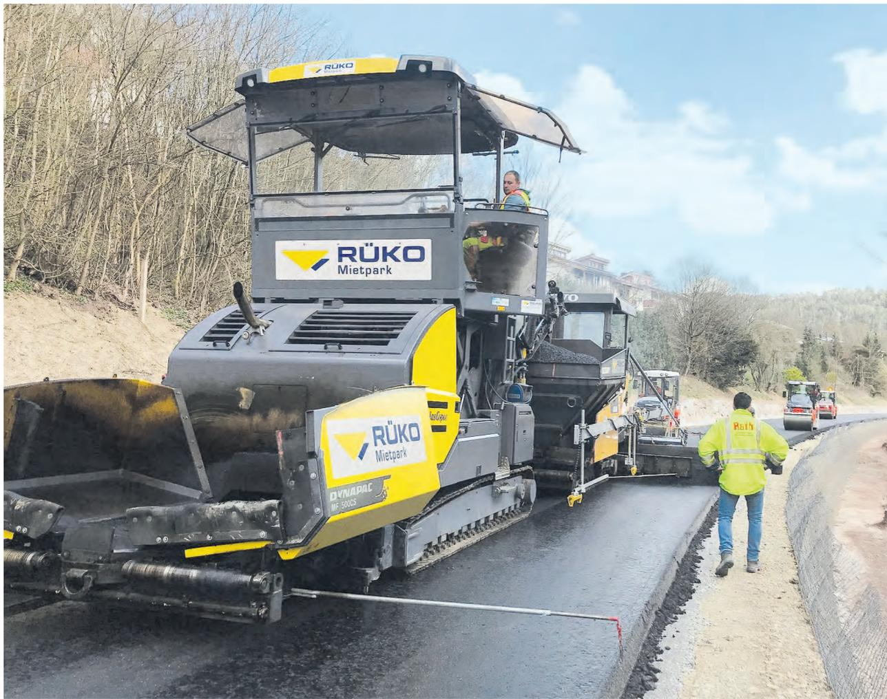
Für die Fahrbahnsanierung der L 349 bei Wildberg arbeitete die Rath GmbH mit dem Baumaschinenvermieter Rüko zusammen. Die Rath-Mitarbeiter setzten einen gemieteten Dynapac-Beschicker des Typs MF 2500 CS ein, um eine rund 1300 m lange Strecke zu erneuern. FOTO: RÜKO
