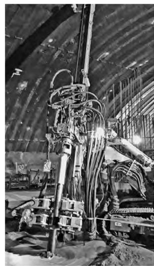
Das Unternehmen setzt eigenen Angaben zufolge bis zu fünf Bohrgeräte gleichzeitig ein, darunter Maschinen der Typen KR 806 und KR 909 von Klemm. FOTO: BAUER
