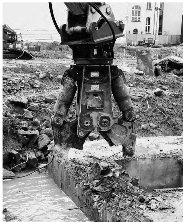
Derzeit unterstützt ein MBI-Combicutter des Typs CC65R in Berlin den Rückbau eines aus DDR-Zeiten stammenden Fertigteilbaus. FOTO: MBI DEUTSCHLAND
